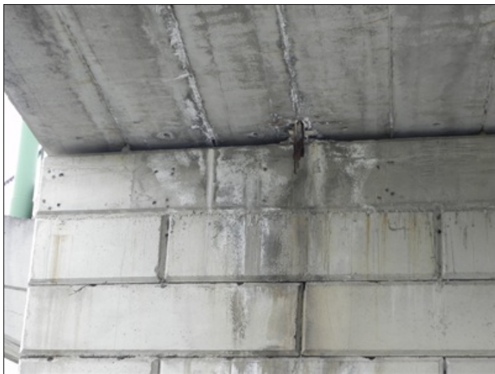
Detail. Nad OP1 - zatékání v místě odvodňovače pod NK
