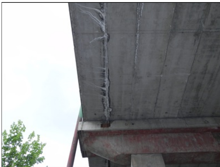
Detail. Zatékání nad podpěrrou č. 2
