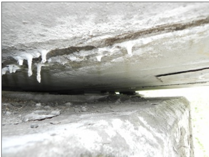
Detail. OP3, místo uložení - posunutá ložiska
