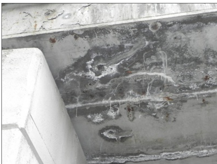
Detail. Nad OP3, LS - zatékání, krápníky v krajním poli
