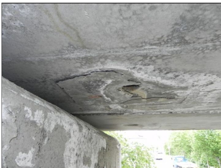
Detail. Odlupování krycí vrstva v okolí odvodnění nosníků.
