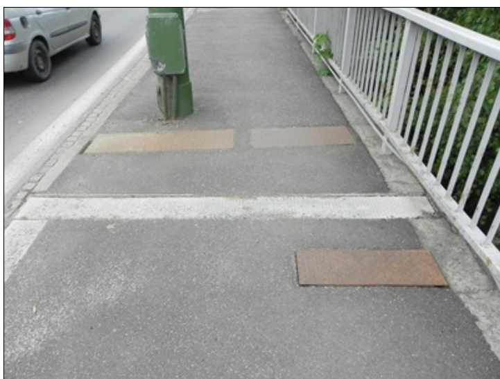
Detail. Zakrytí vstupů do kabelových kanálků, chráničky pro vedení různých sítí. Nezaizolováno, zatéká.
